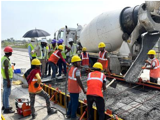
(コンクリート道床の建設訓練)
