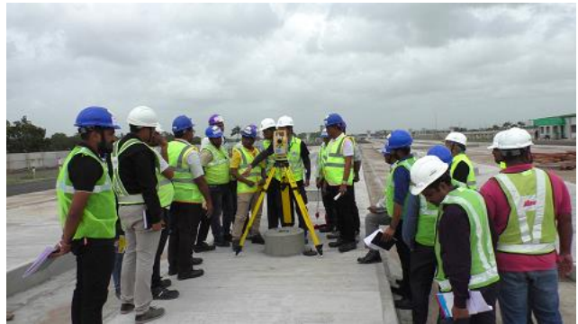
(軌道敷設位置を決めるための測量訓練)
